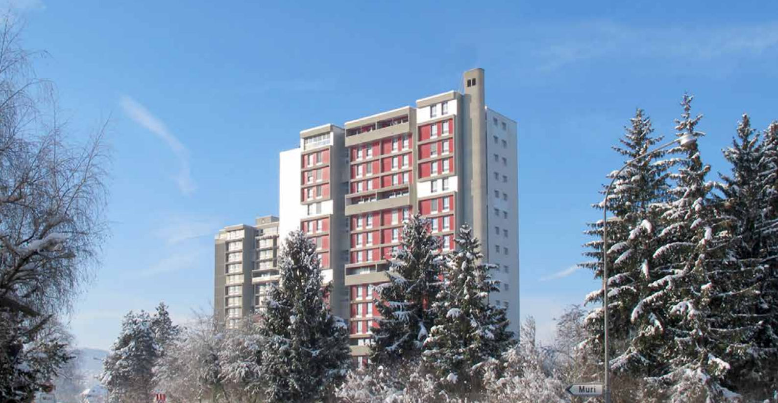
Sanierung eines Mehrfamilienhauses in Muri bei Bern
